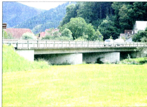
Bereitet schon seit mehreren Jahren einige Probleme: Die B33-Brücke bei Gutach-Turm. Foto: Gräff
